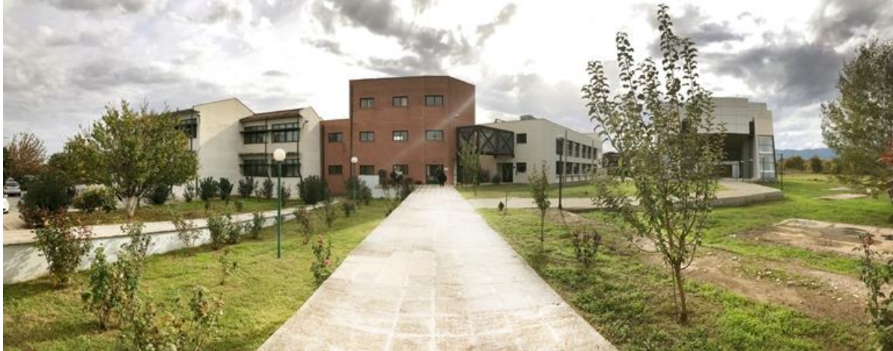
Μέρος των εγκαταστάσεων του ΤΕΦΑΑ.
